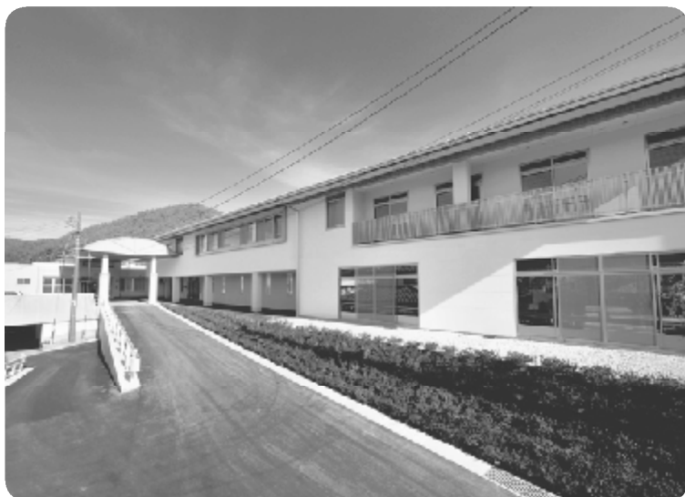
増築の新棟全景
