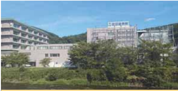
2023年9月13日：病院西側全景
